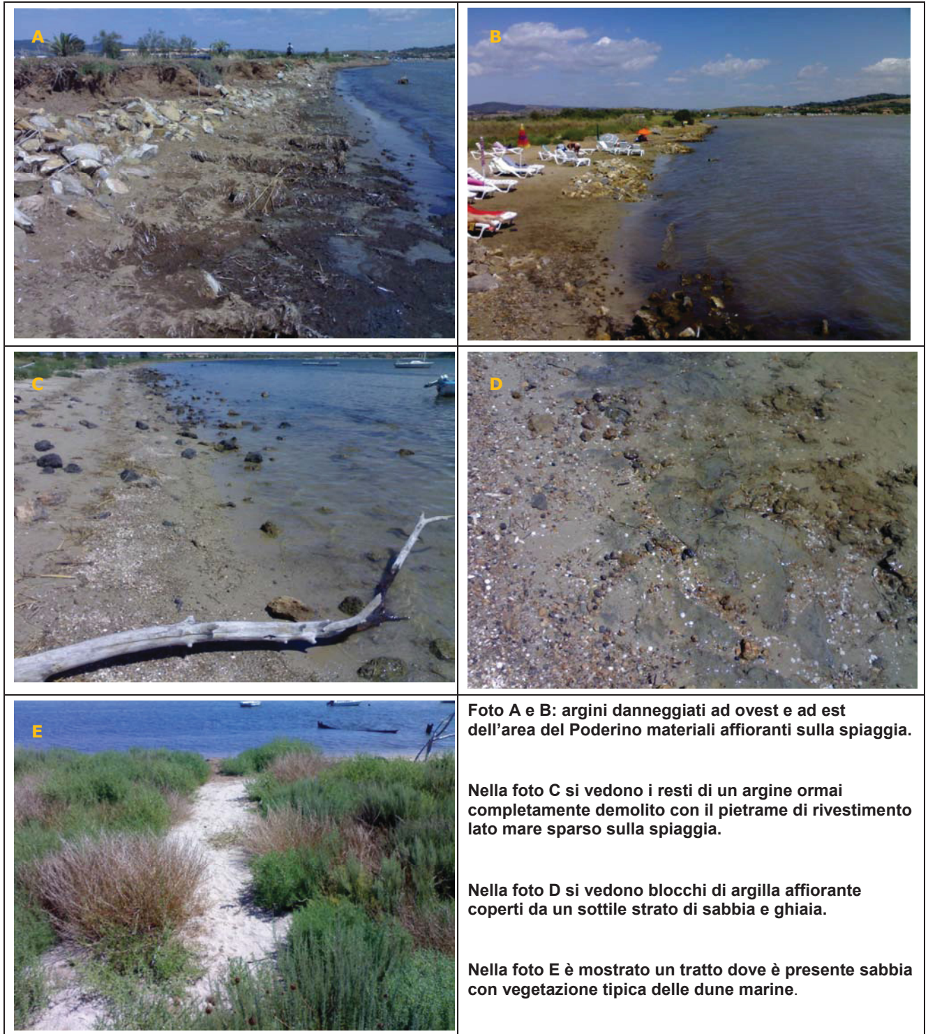
Figura 1 Immagini dell'argine a mare
